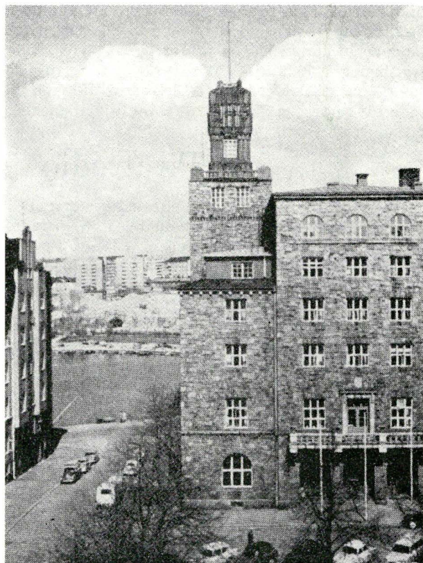
Folkets hus er bygget af sten fra den klippe, der lå på grunden, hvor bygningen ligger. Mange arbejdere har lagt hundreder af arbejdstimer ved opførelsen uden vederlag.
